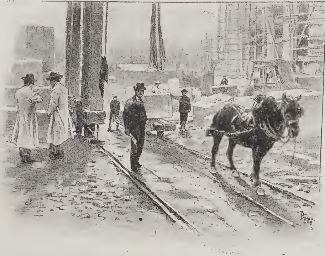
LES TRAVAILLEURS DE L'EXPOSITION. Bardeurs amenant une pierre de taille, sous la grande grue.
